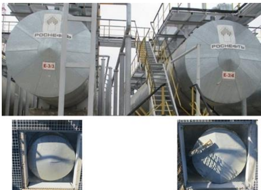
Рисунок 13 – Общий вид резервуаров стальных горизонтальных цилиндрических РГС-200 с заводскими номерами E-3/3, E-3/4
