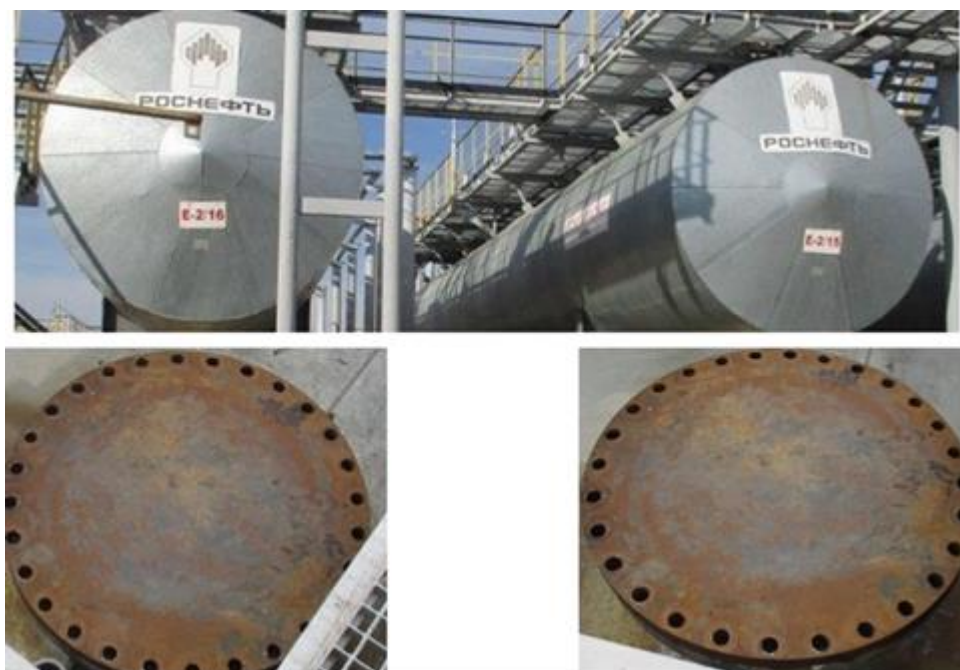
Рисунок 11 – Общий вид резервуаров стальных горизонтальных цилиндрических РГС-200 с заводскими номерами E-2/15, E-2/16
