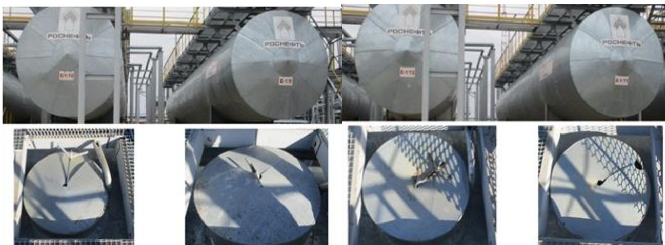
Рисунок 3 – Общий вид резервуаров стальных горизонтальных цилиндрических РГС-200 с заводскими номерами E-1/9, E-1/10, E-1/11, E-1/12
