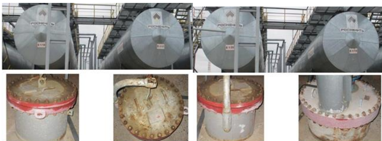
Рисунок 5 – Общий вид резервуаров стальных горизонтальных цилиндрических РГС-200 с заводскими номерами Е-1/17, Е-1/18, Е-1/19, Е-1/20
