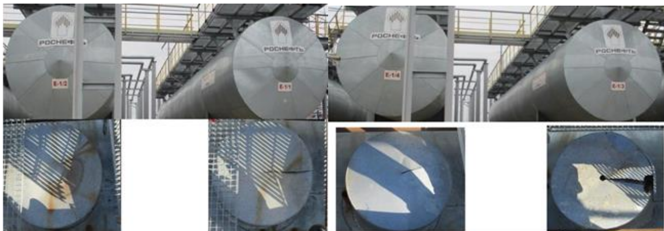
Рисунок 1 – Общий вид резервуаров стальных горизонтальных цилиндрических РГС-200 с заводскими номерами E-1/1, E-1/2, E-1/3, E-1/4
