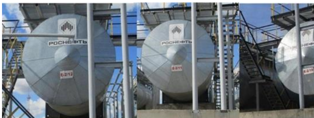
Рисунок 8 – Общий вид резервуаров стальных горизонтальных цилиндрических РГС-200 с заводскими номерами Е-2/7, Е-2/8, Е-2/9
