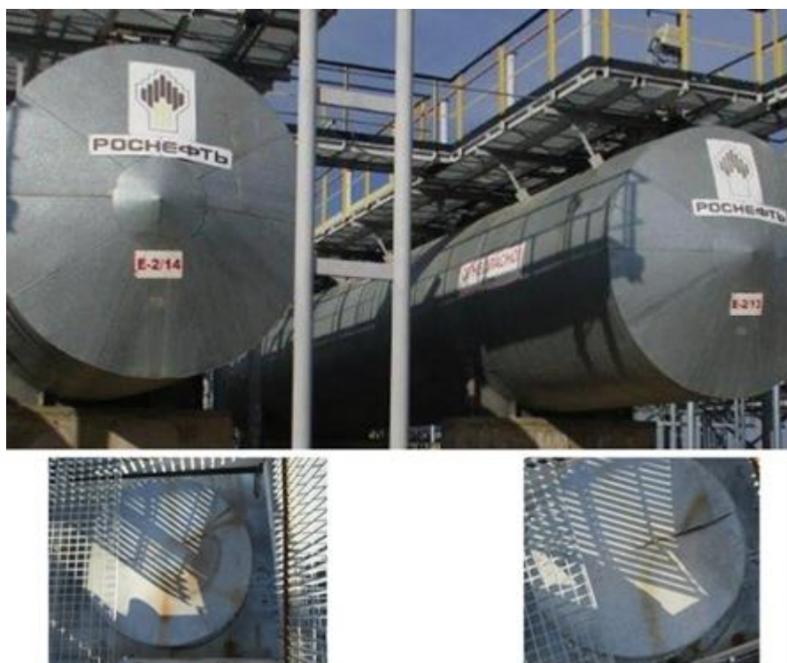
Рисунок 10 – Общий вид резервуаров стальных горизонтальных цилиндрических РГС-200 с заводскими номерами E-2/13, E-2/14
