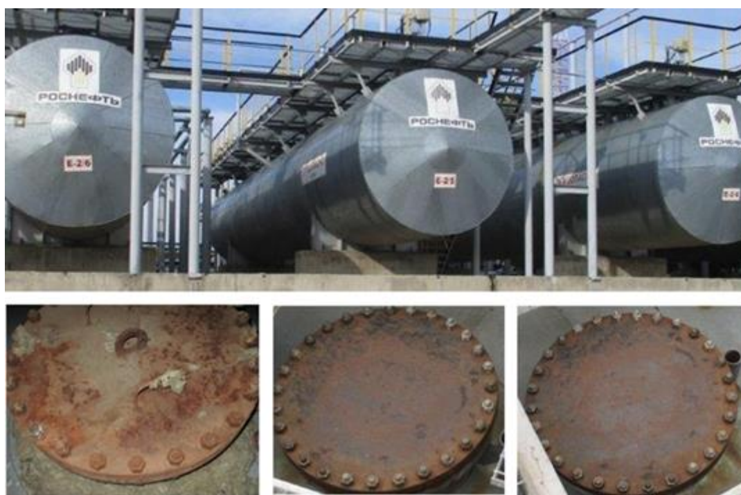
Рисунок 7 – Общий вид резервуаров стальных горизонтальных цилиндрических РГС-200 с заводскими номерами Е-2/4, Е-2/5, Е-2/6
