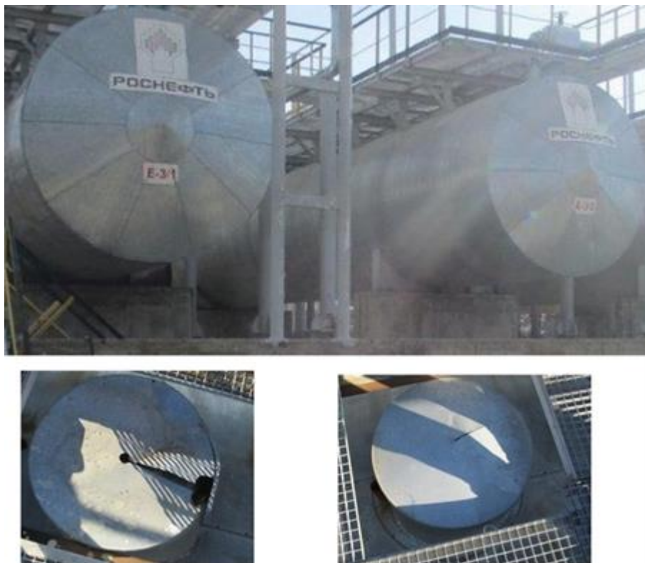
Рисунок 12 – Общий вид резервуаров стальных горизонтальных цилиндрических РГС-200 с заводскими номерами E-3/1, E3/2
