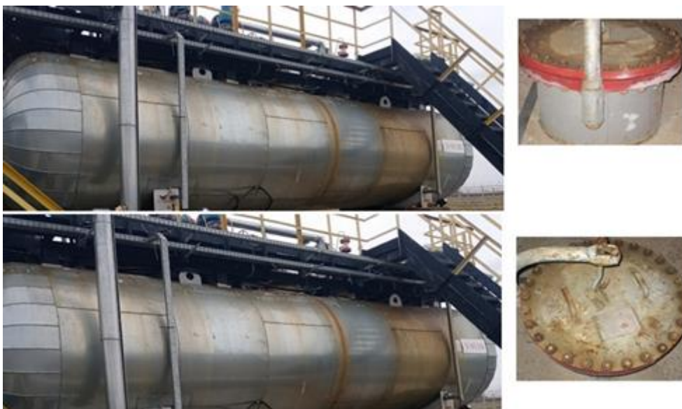
Рисунок 1 – Общий вид резервуаров стальных горизонтальных цилиндрических РГС-25 (заводские номера V-911А, V-911В)
