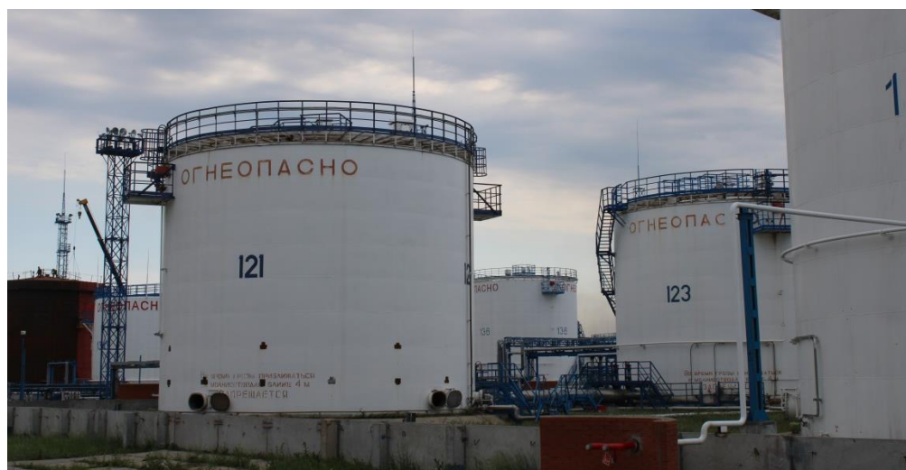
Рисунок 1 – Общий вид резервуаров
