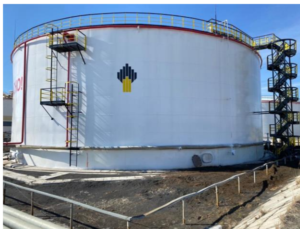
Рисунок 1 – Общий вид резервуара стального вертикального цилиндрического РВС-10000
