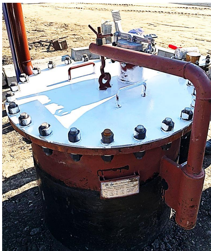
Рисунок 2 – Горловины и замерной люк резервуара стального горизонтального цилиндрического РГС-8.
