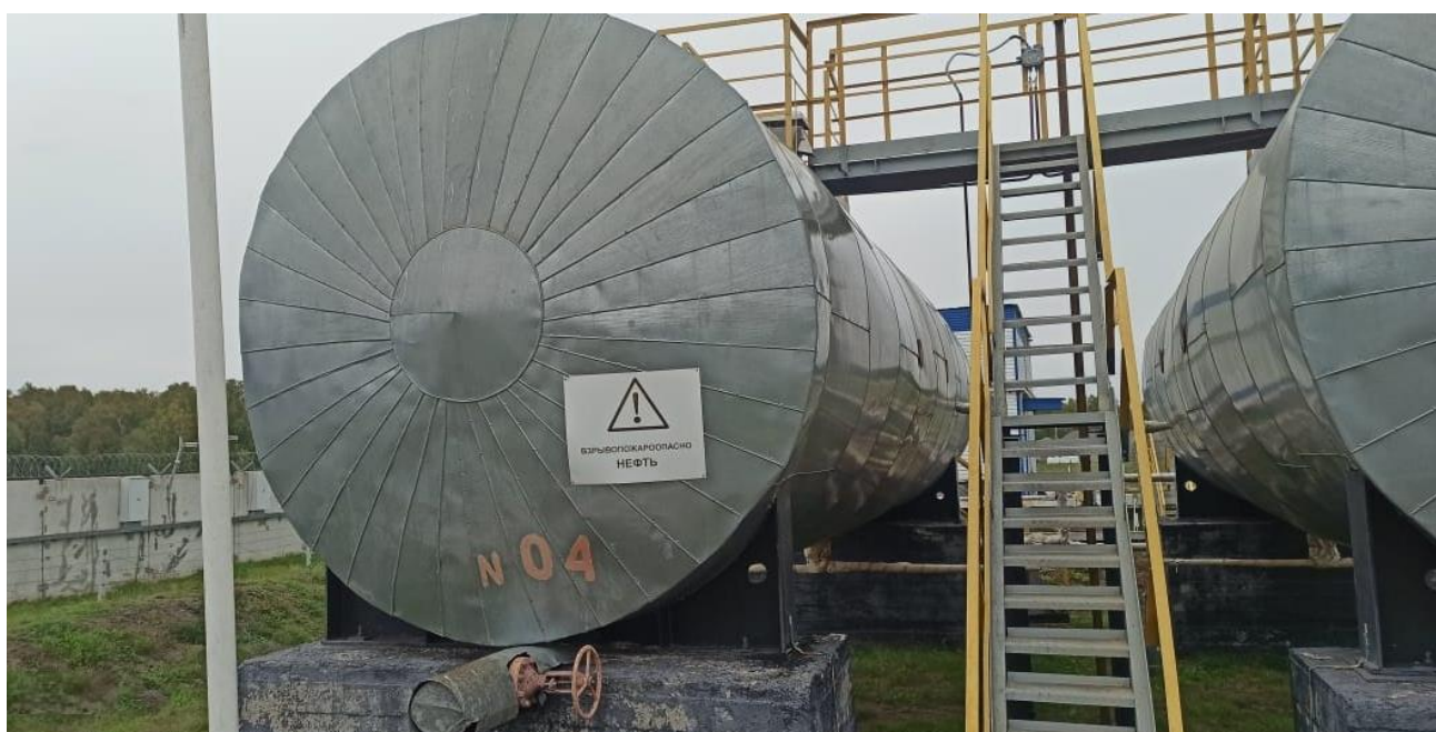
Рисунок 2 – Общий вид резервуара РГС-80 с заводским номером 04
