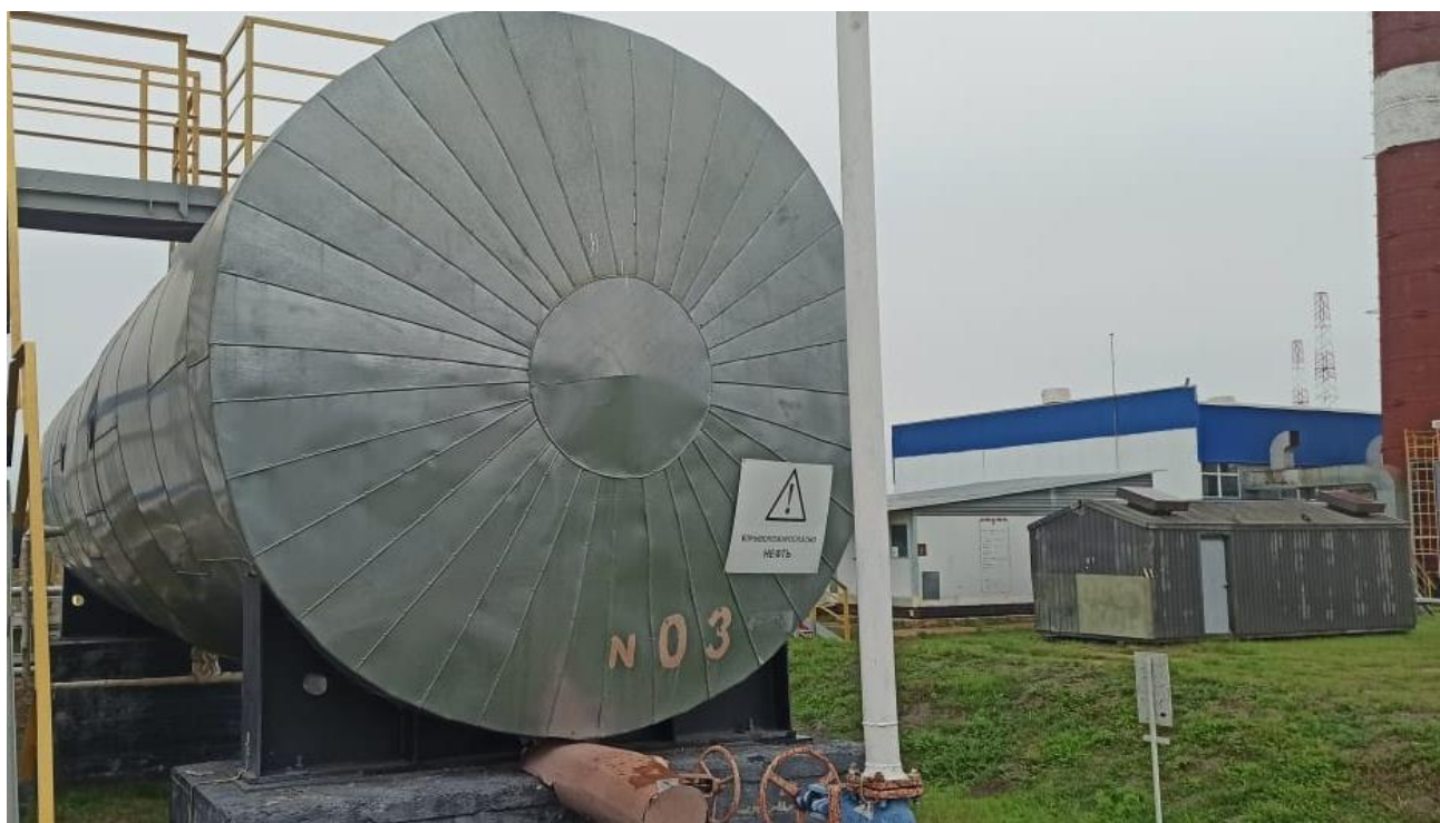
Рисунок 1 – Общий вид резервуара РГС-80 с заводским номером 03
