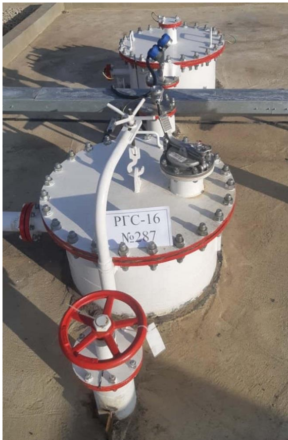
Рисунок 2 – Общий вид резервуаров РГС-16
