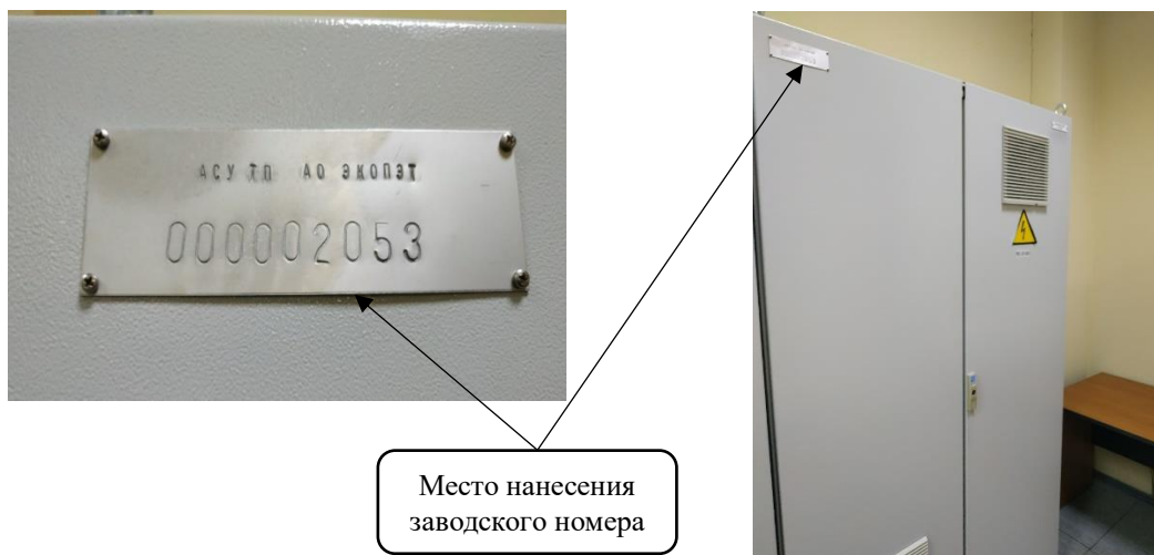
Рисунок 3 – Общий вид средний уровень (шкаф с контроллерами) и место нанесения заводского номера
