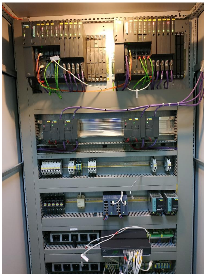
Рисунок 2 – Общий вид среднего уровня (контроллеры CPU 417-4 Н Primary)
