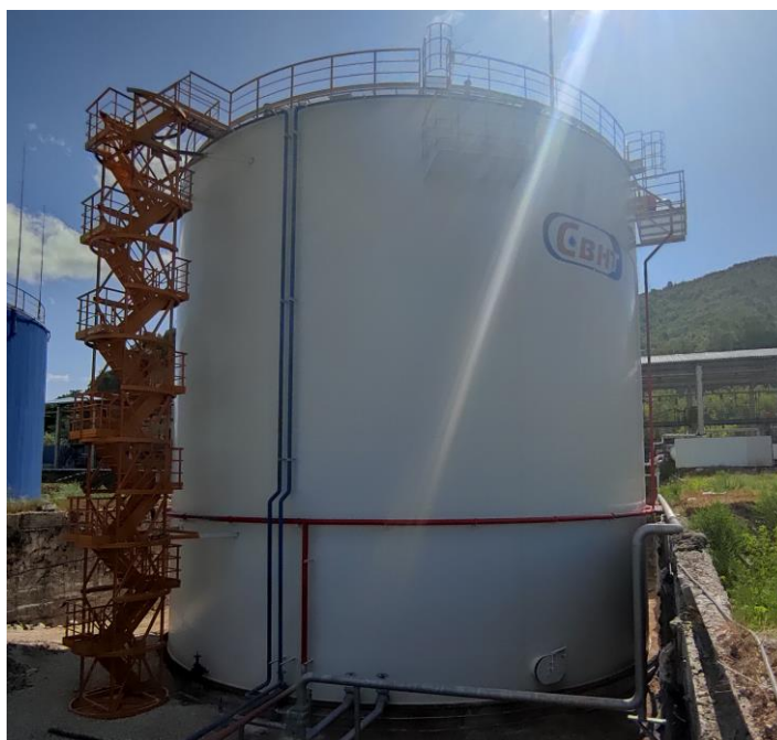
Рисунок 1 – Общий вид резервуара
