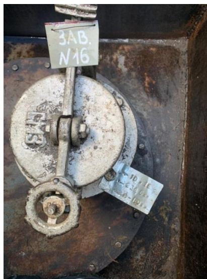
Рисунок 2 – Фотография горловины и заводского номера резервуара стального горизонтального цилиндрического РГС-10, заводской номер 16
