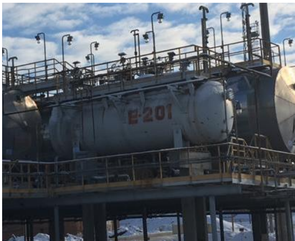
Рисунок 1 - Общий вид резервуара стального горизонтального цилиндрического РГС-20
