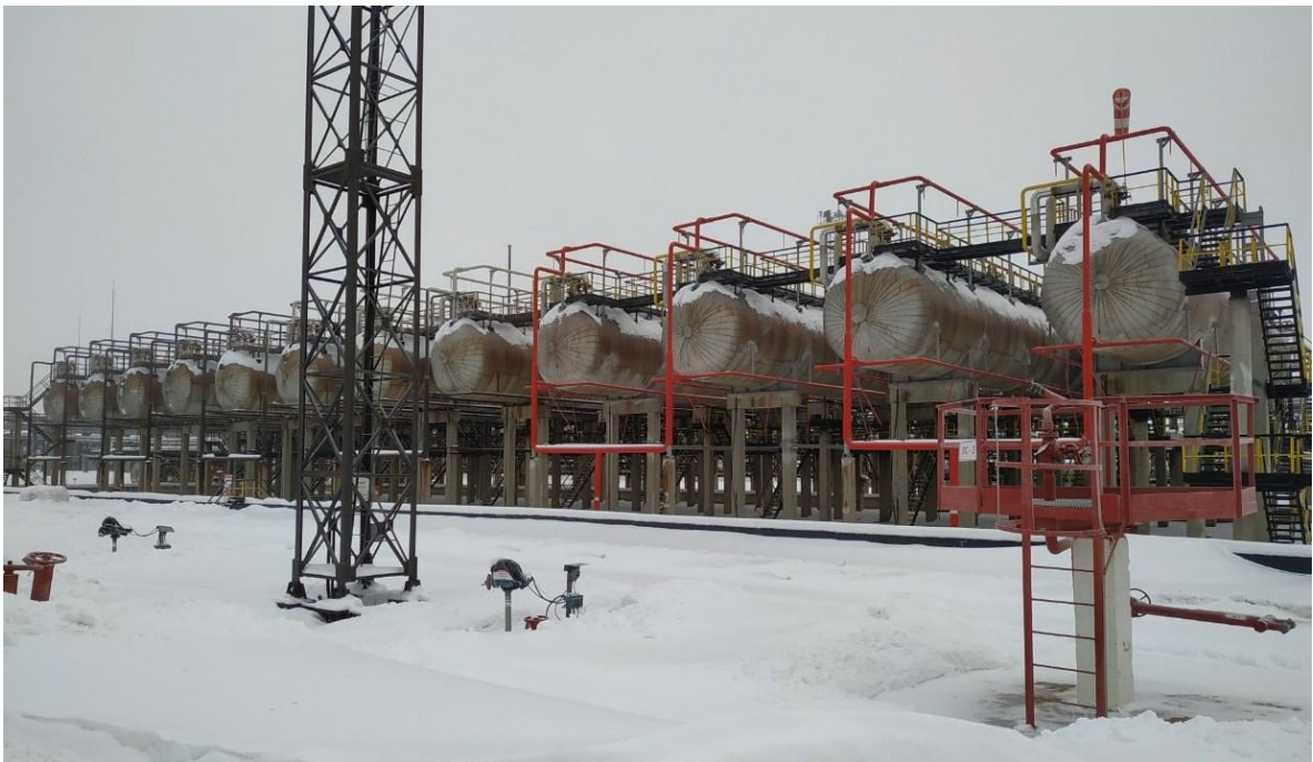
Рисунок 1 - Общий вид резервуара стального горизонтального цилиндрического РГС-200
