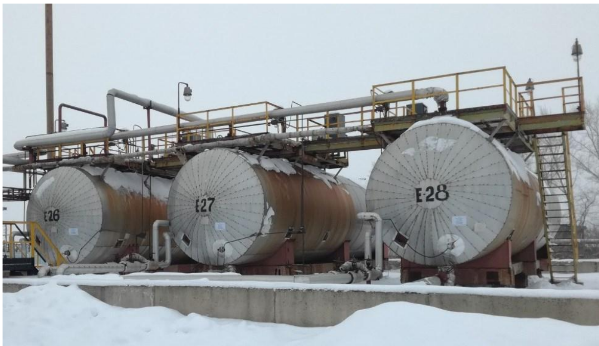
Рисунок 1 - Общий вид резервуара стального горизонтального цилиндрического РГС-100
