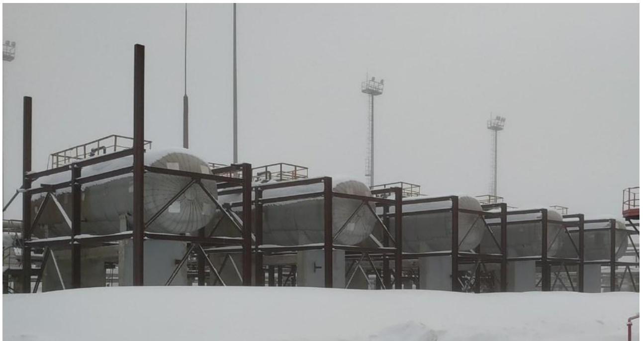
Рисунок 1 - Общий вид резервуара стального горизонтального цилиндрического РГС-90
