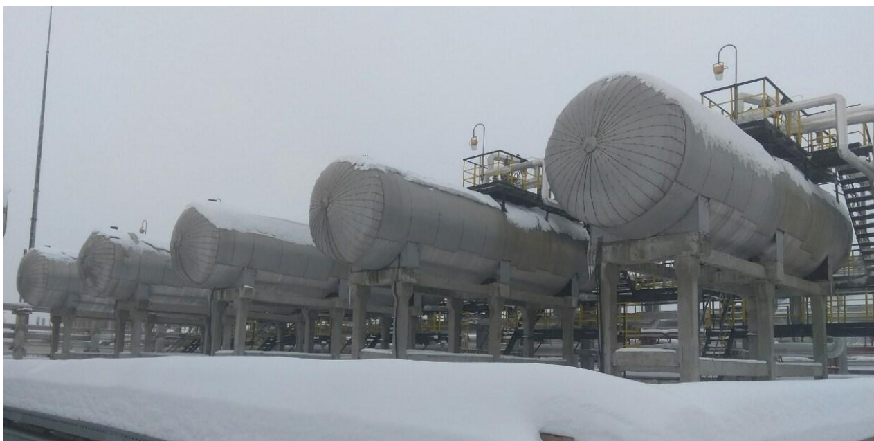
Рисунок 2 - Общий вид резервуара стального горизонтального цилиндрического РГС-100
