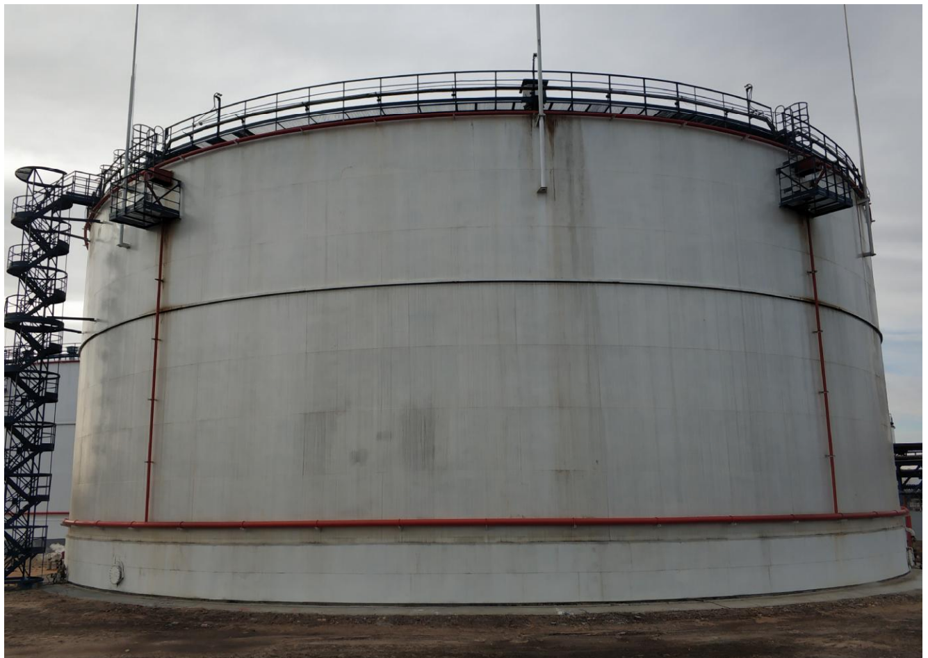
Рисунок 1 - Общий вид резервуара РВС-30000
