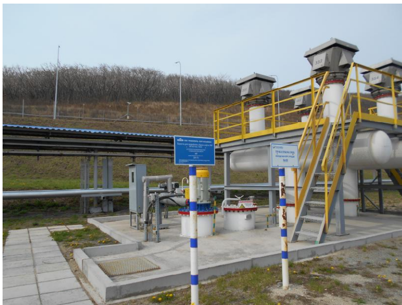
Рисунок 1 - Общий вид площадки размещения резервуара РГС-63 № 58563
