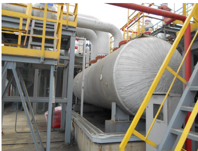
Рисунок 1 - Общий вид резервуара РГС-40 № 221-30
