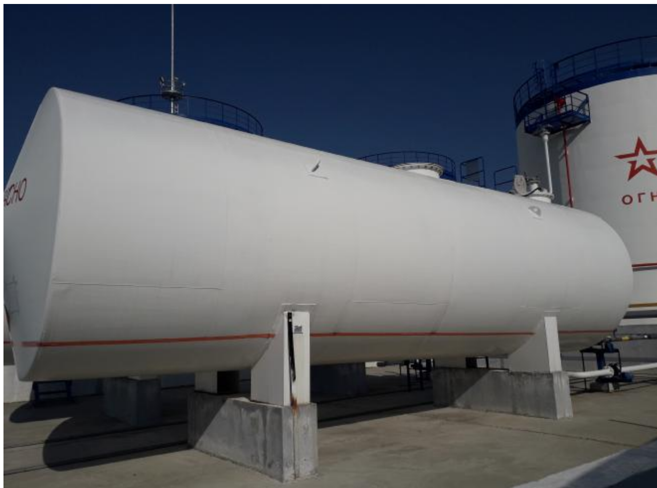
Рисунок 1 – Общий вид резервуара РГС-50
