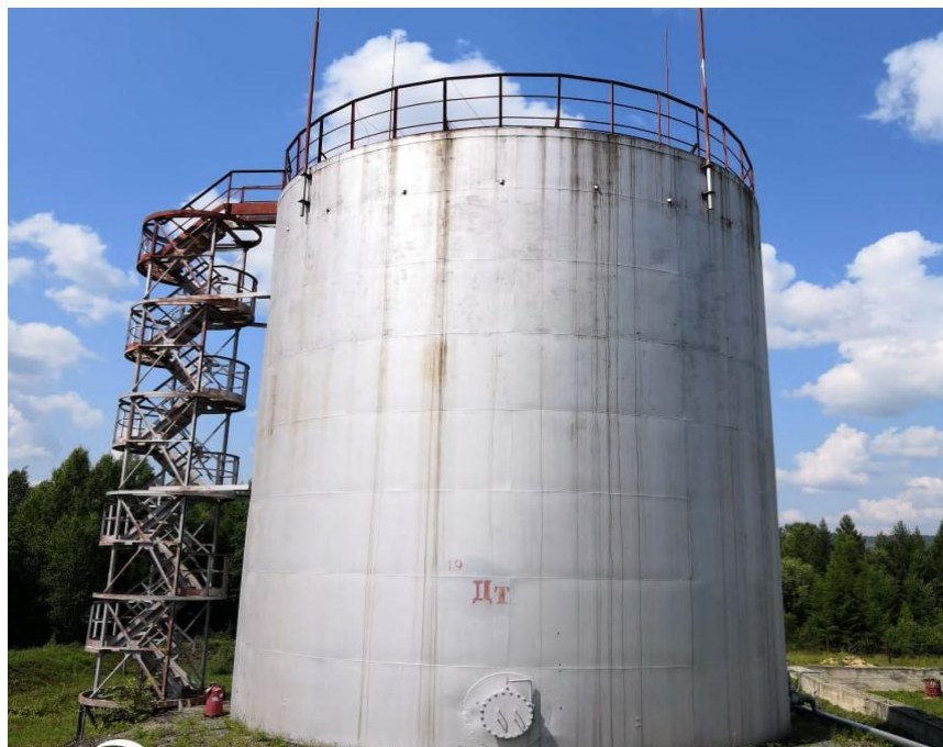
Рисунок 1 – Общий вид резервуара стального вертикального цилиндрического РВС-1000
