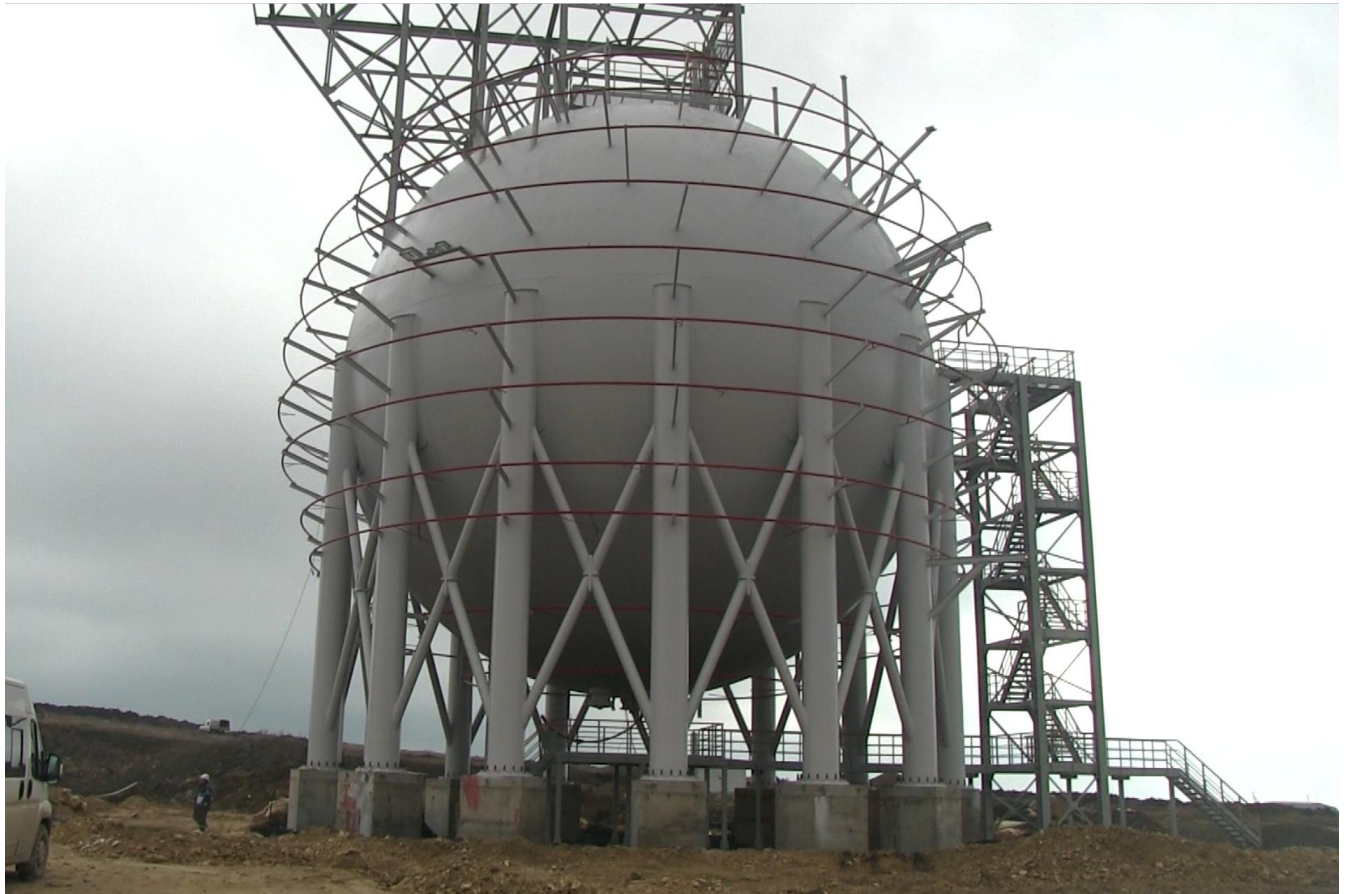
Рисунок 1 - Общий вид резервуаров
