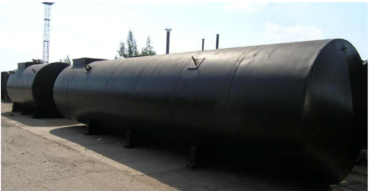
Рисунок 1 - Общий вид резервуаров
