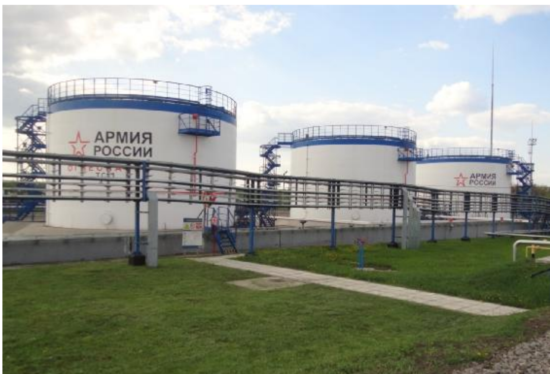
Рисунок 1 – Общий вид резервуаров стальных вертикальных цилиндрических РВС-1629
