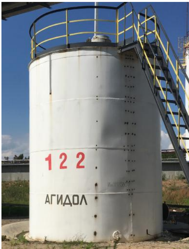
Рисунок 1 – Общий вид резервуара стального вертикального цилиндрического РВС-100
