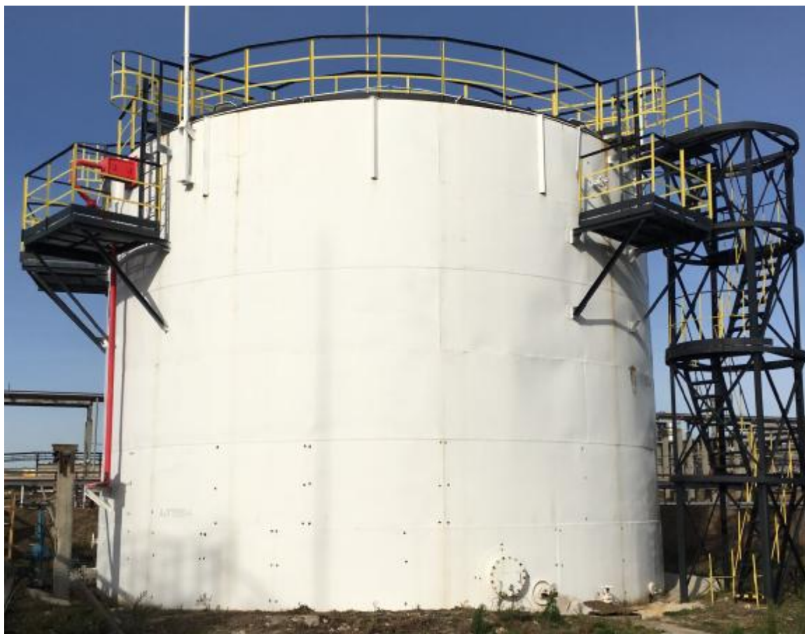
Рисунок 2 – Общий вид резервуара стального вертикального цилиндрического РВСП-1000
