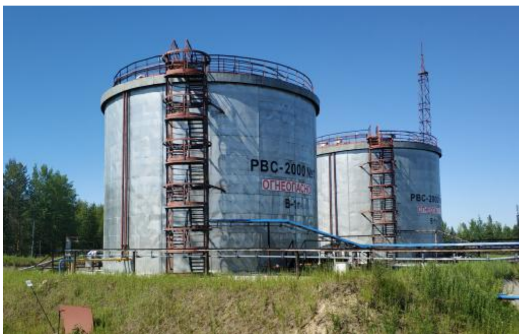
Рисунок 1 - Общий вид резервуаров стальных вертикальных цилиндрических РВС-2000
