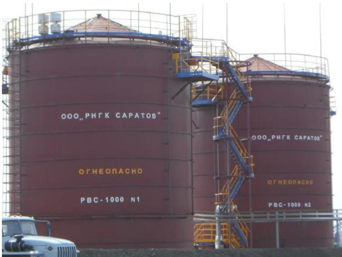
Рисунок 1 – Резервуар вертикальный стальной РВС-1000
