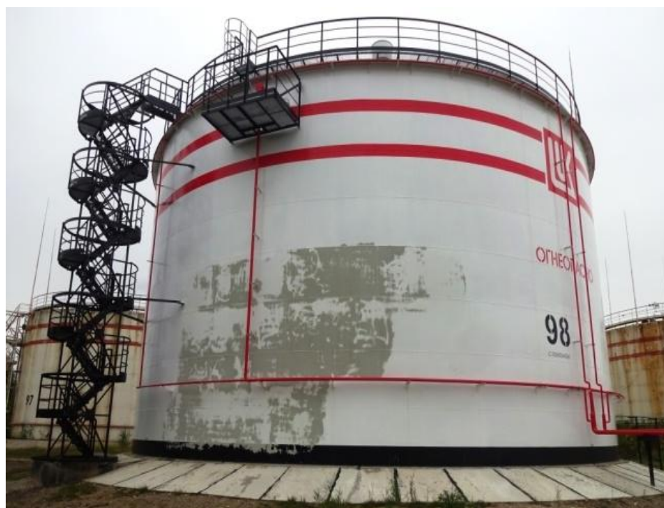
Рисунок 1 – Общий вид резервуара РВСП-5000 № 98
