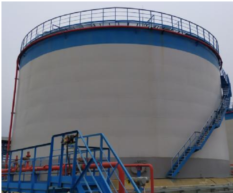
Рисунок 1 – Общий вид резервуаров стальных вертикальных цилиндрических РВС-5000
