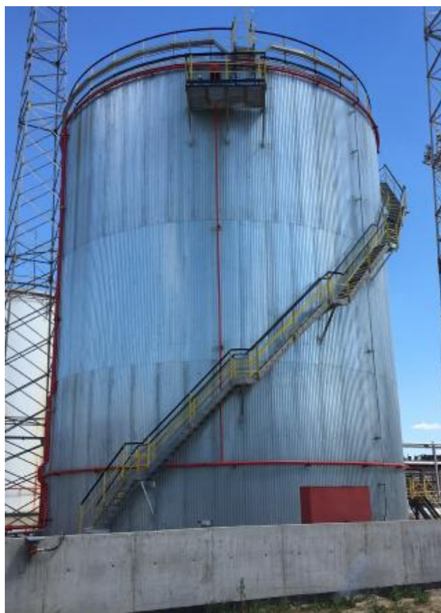
Рисунок 1 – Общий вид резервуара стального вертикального цилиндрического РВС-3000
