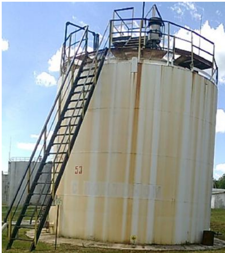
Рисунок 2 – Общий вид резервуара стального вертикального цилиндрического РВСП-200
