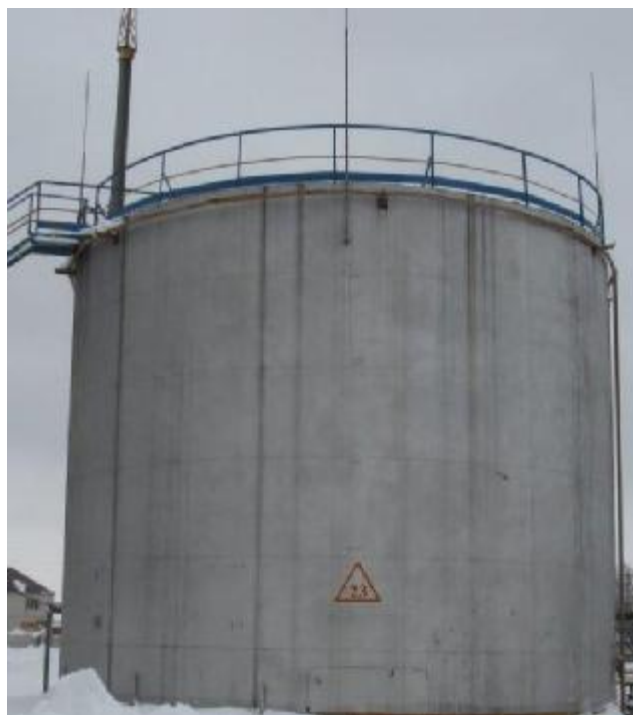
Рисунок 2 – Общий вид резервуара стального вертикального цилиндрического РВС-700, РВСП-700
