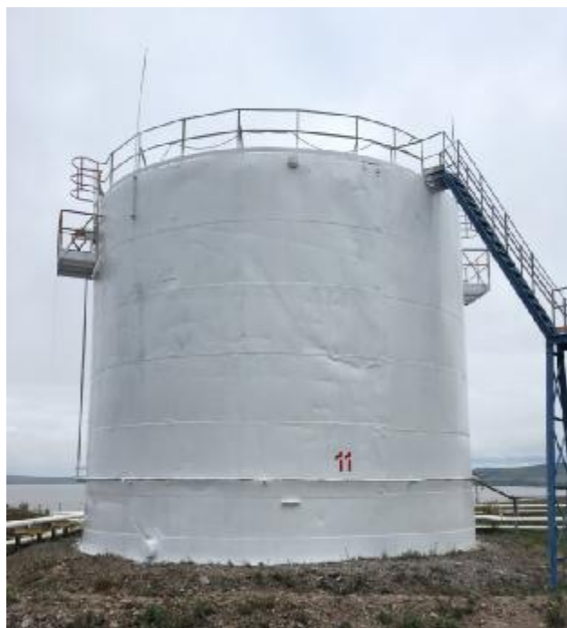
Рисунок 2 – Общий вид резервуара РВС-1000 заводской № 11
