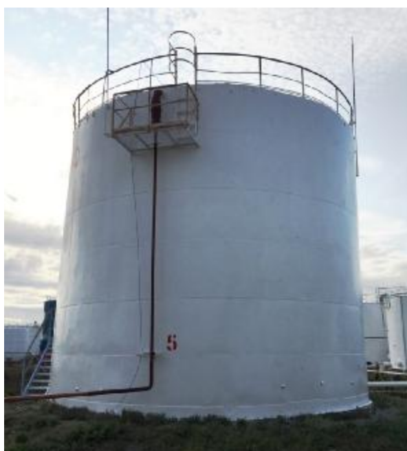
Рисунок 1 – Общий вид резервуара РВС-700 заводской № 5
