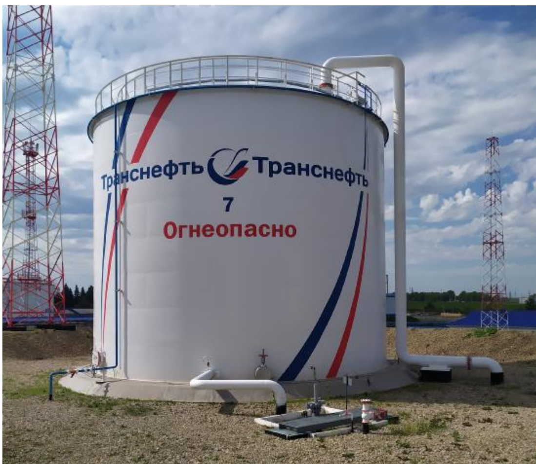
Рисунок 1 – Общий вид резервуара РВС-2000
