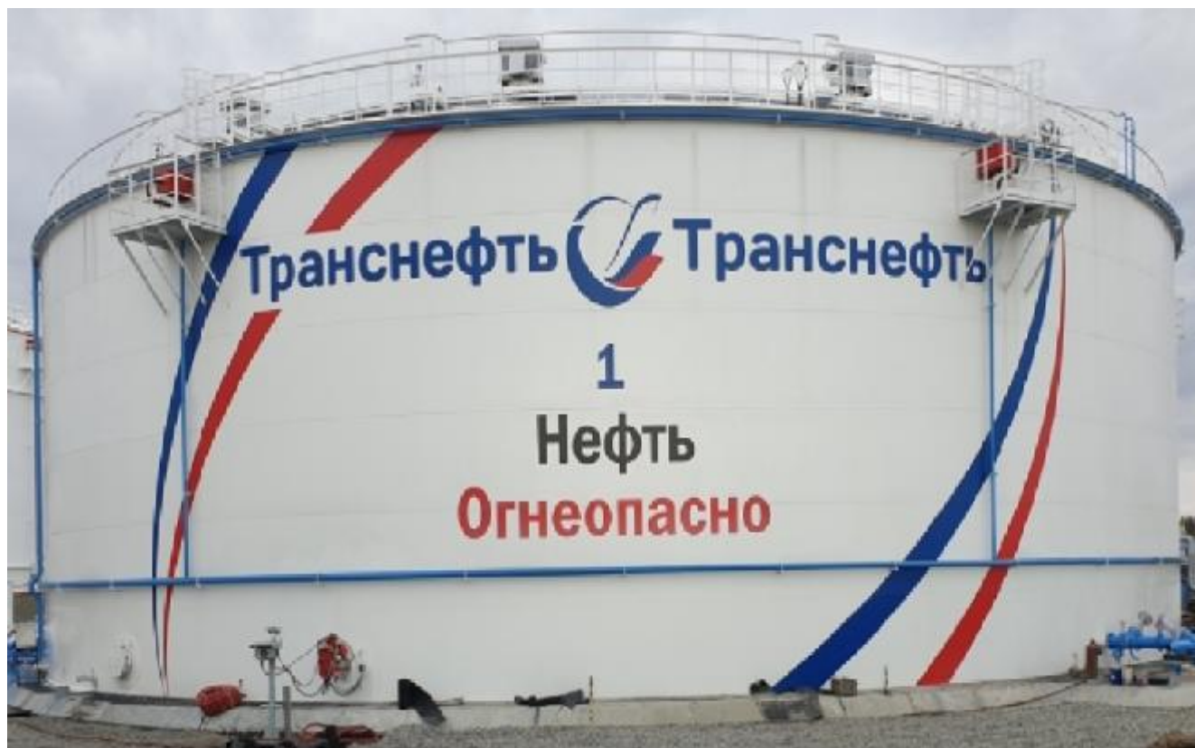
Рисунок 1 – Общий вид резервуара РВС-20000
