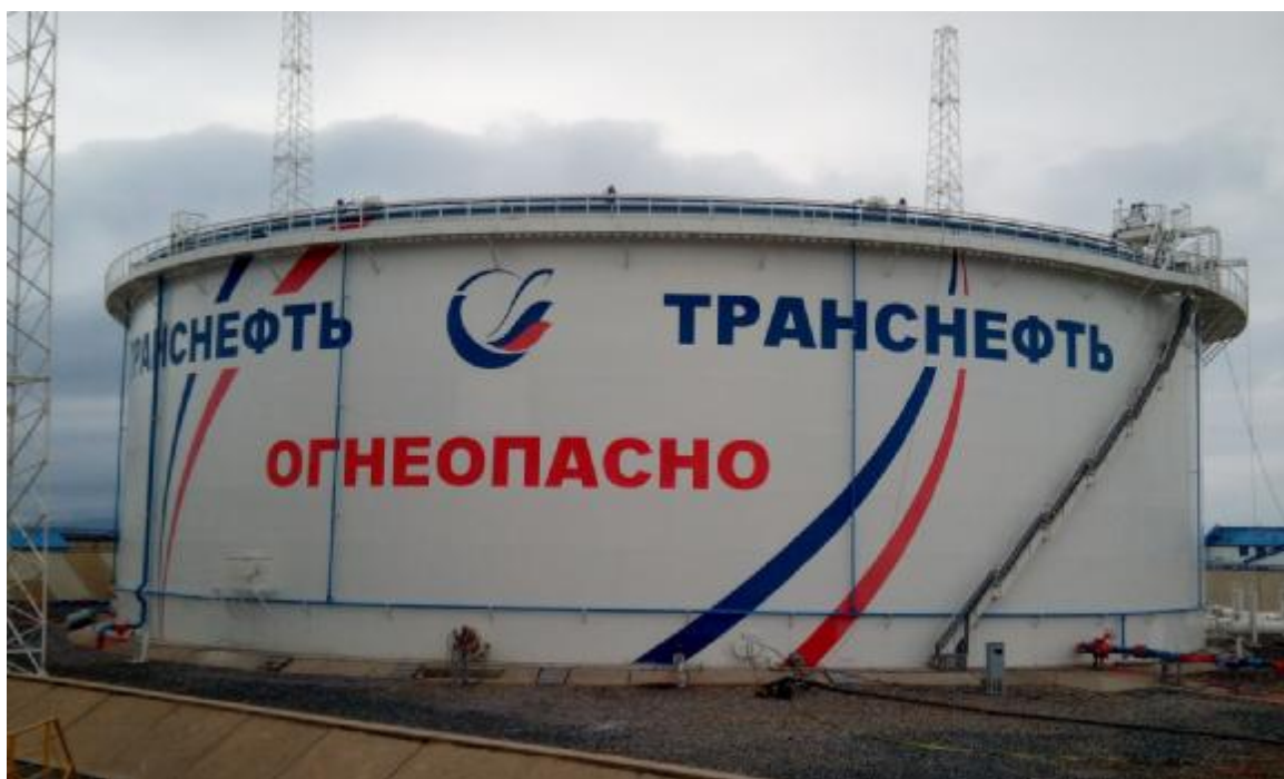
Рисунок 1 – Общий вид резервуаров РВСПК-50000 зав.№№ 1, 3, 4, 7
