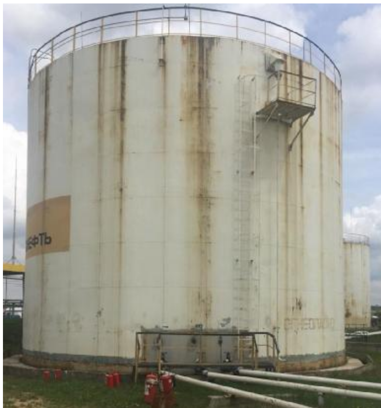
Рисунок 1 – Общий вид резервуара стального вертикального цилиндрического РВС-2000
