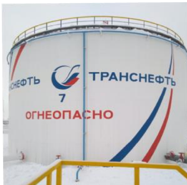
Рисунок 1 – Общий вид резервуара РВС-5000 зав.№ 7
