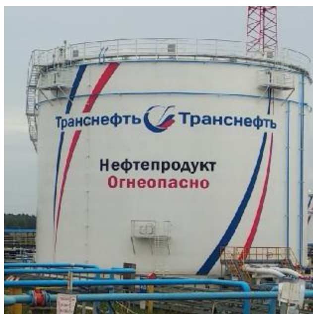
Рисунок 5 – Общий вид резервуаров РВСП-7500 зав.№№ 9, 10,11, 12
