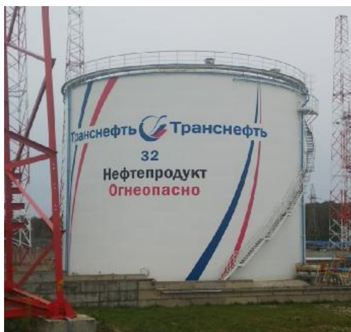
Рисунок 2 – Общий вид резервуара РВС-7500 зав.№ 32
