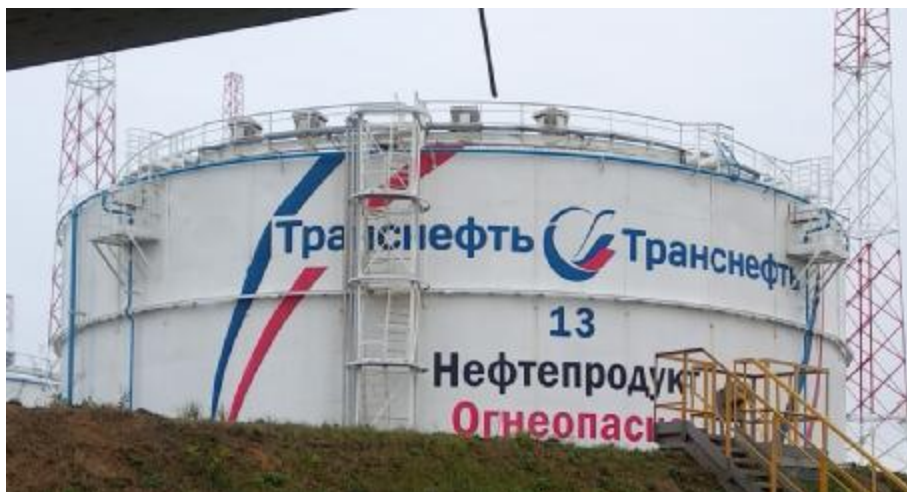
Рисунок 3 – Общий вид резервуара РВС-10000 зав.№ 13
