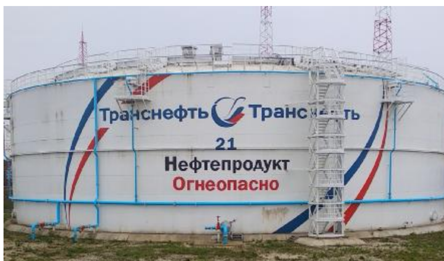
Рисунок 4 - Общий вид резервуара РВС-20000 зав.№ 21
