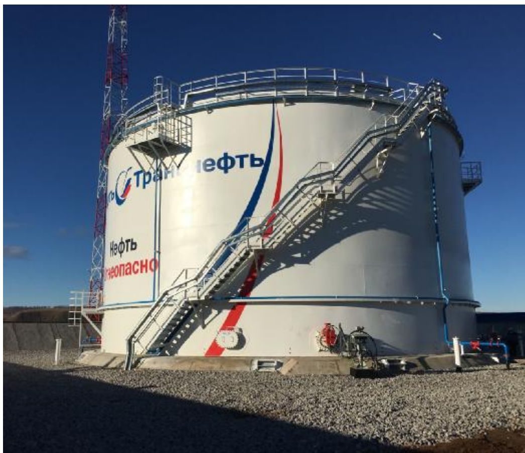
Рисунок 2 – Общий вид резервуаров РВСП-5000 зав.№№ 1, 2, 14
