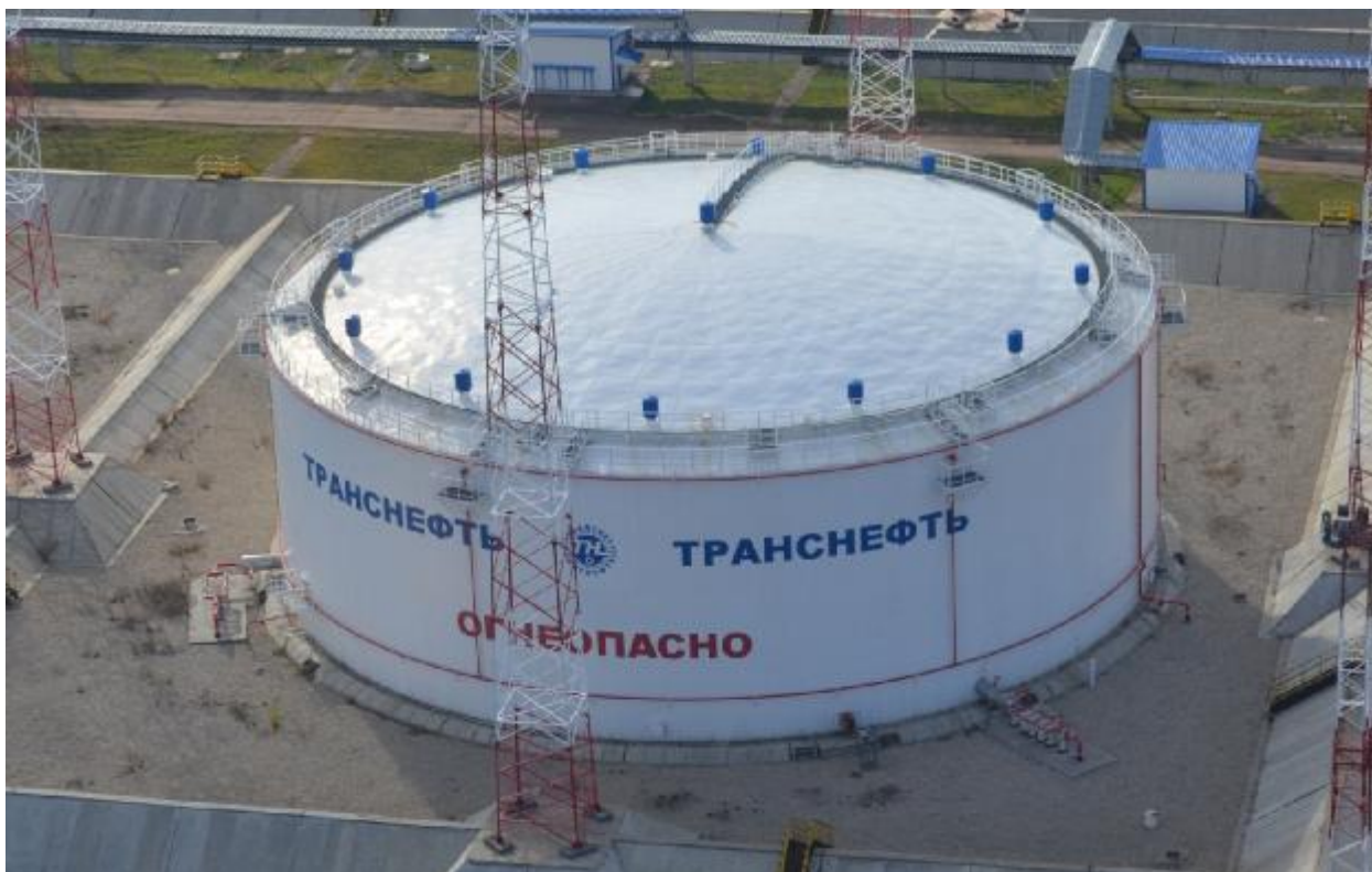
Рисунок 1 – Общий вид резервуаров РВСП-20000 зав.№№ 3, 5, 10, 17, 23, 34, 35, 36, 37
