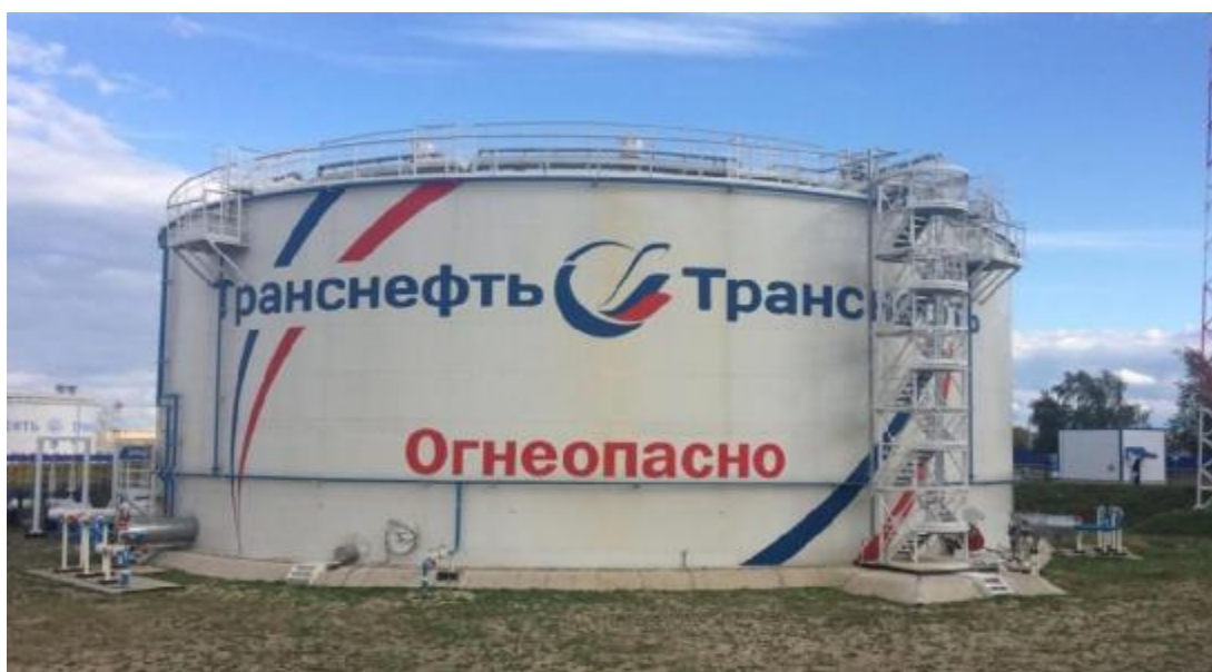
Рисунок 1 – Общий вид резервуаров РВСП-10000 зав.№№ 13, 14, 17
