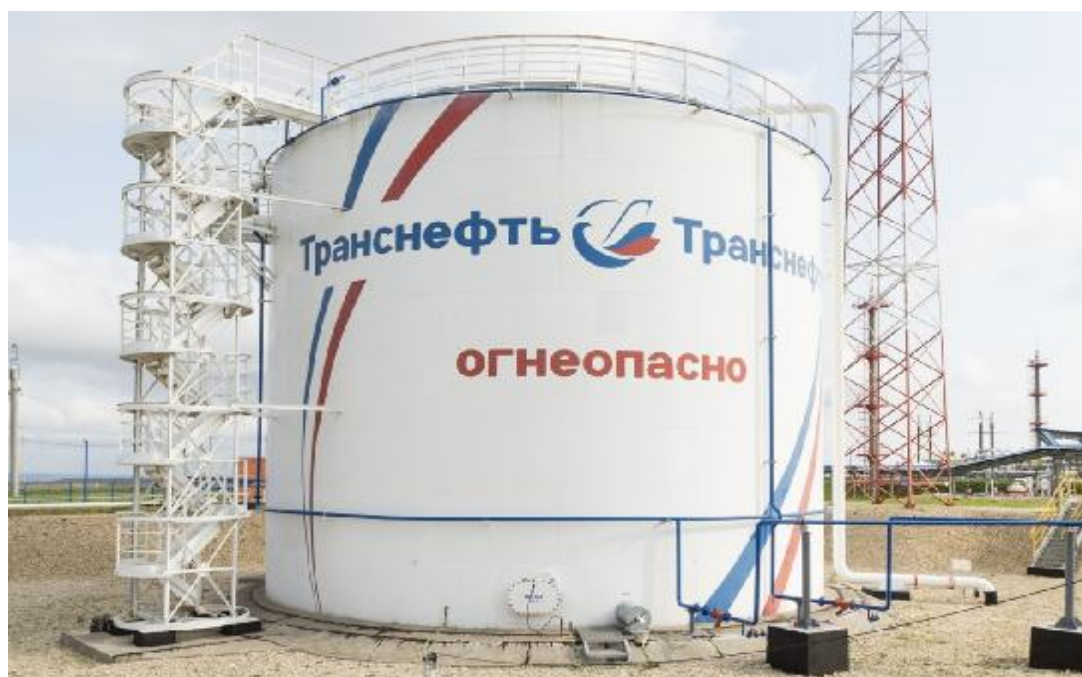
Рисунок 2 – Общий вид резервуаров РВС-2000 зав.№№ 1, 8
