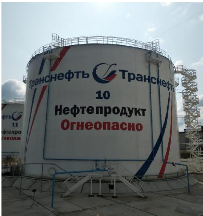
Рисунок 3 – Общий вид резервуара РВС-10000 зав.№ 10
