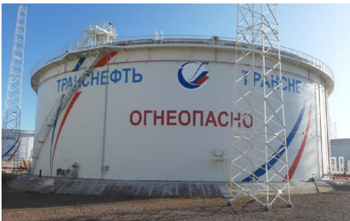
Рисунок 1 – Общий вид резервуаров РВСПК-50000 №№ 11, 12, 15, 16
