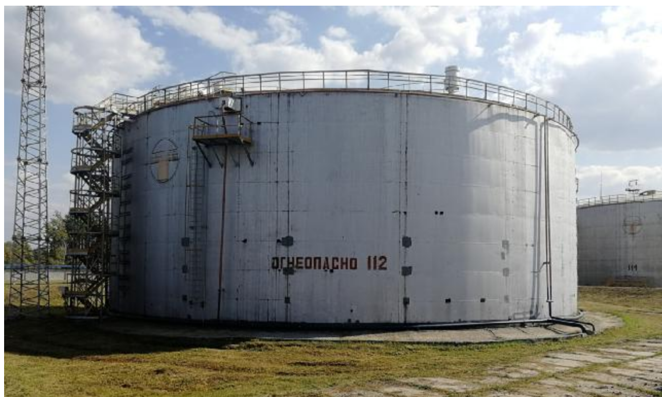
Рисунок 3 – Общий вид резервуара РВС-10000 зав.№ 112
