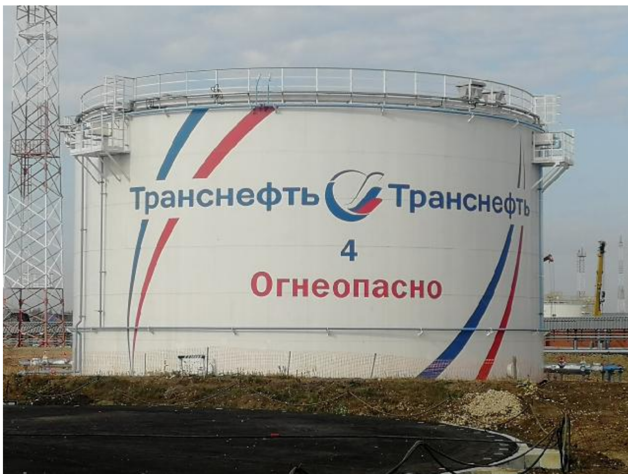
Рисунок 2 – Общий вид резервуара РВС-5000 зав.№ 4
