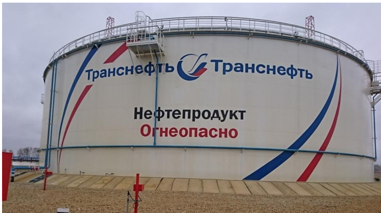
Рисунок 5 – Общий вид резервуаров РВ-20000 зав.№№ 105, 118
