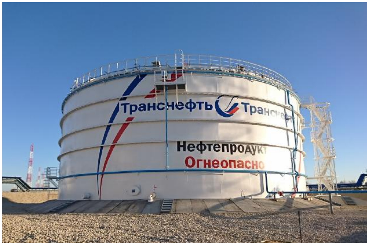
Рисунок 4 – Общий вид резервуаров РВСП-10000 зав.№№ 102, 104
