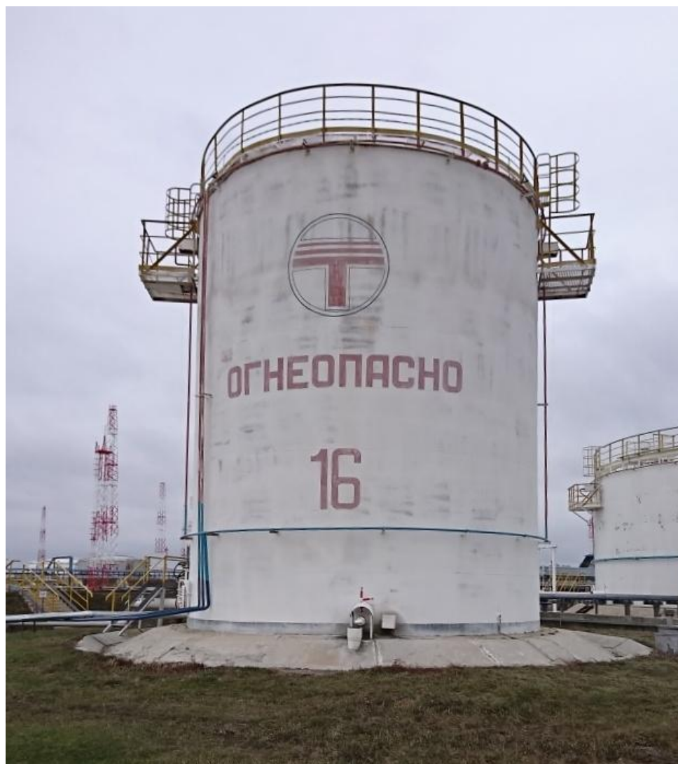
Рисунок 1 – Общий вид резервуара РВСП-1000 зав.№ 16
