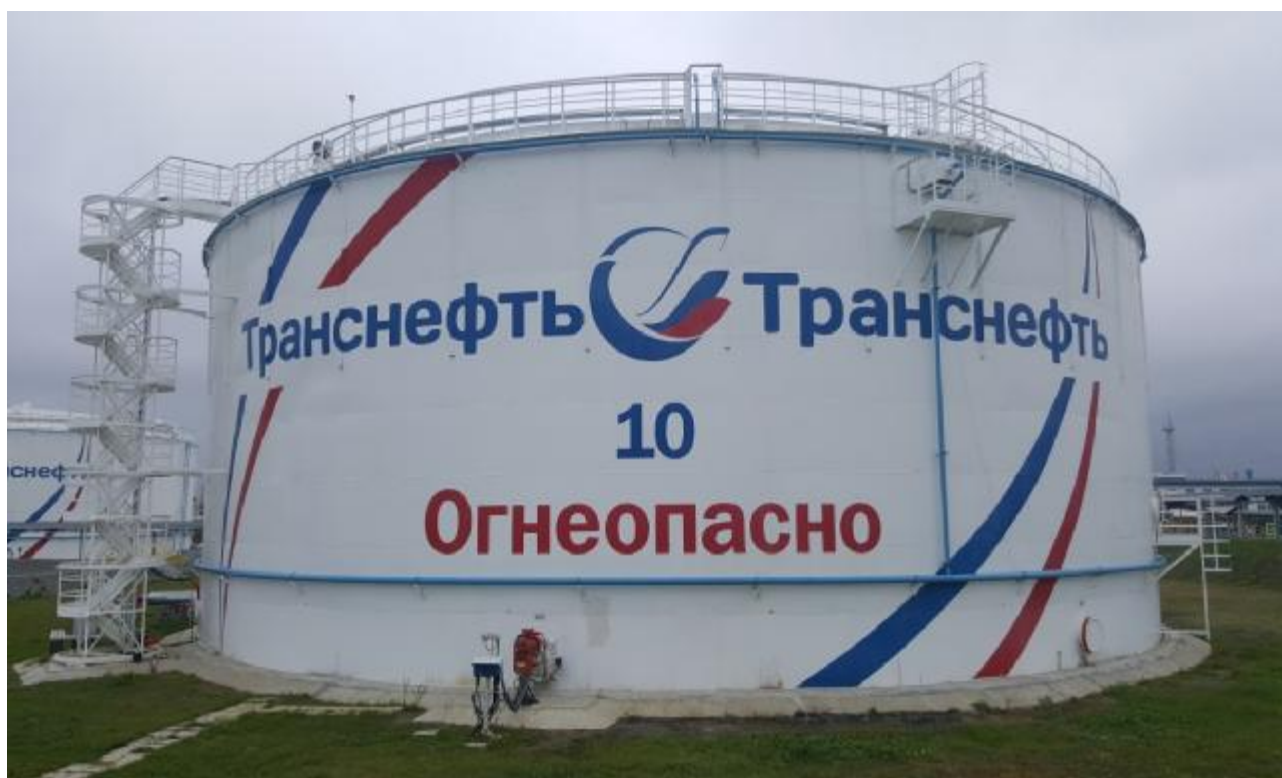
Рисунок 1 – Общий вид резервуара РВСП-10000 зав.№ 10
