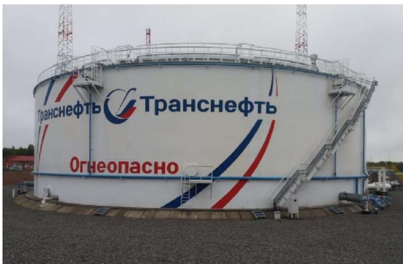
Рисунок 2 – Общий вид резервуаров РВСП-20000 зав.№№ 1, 2
