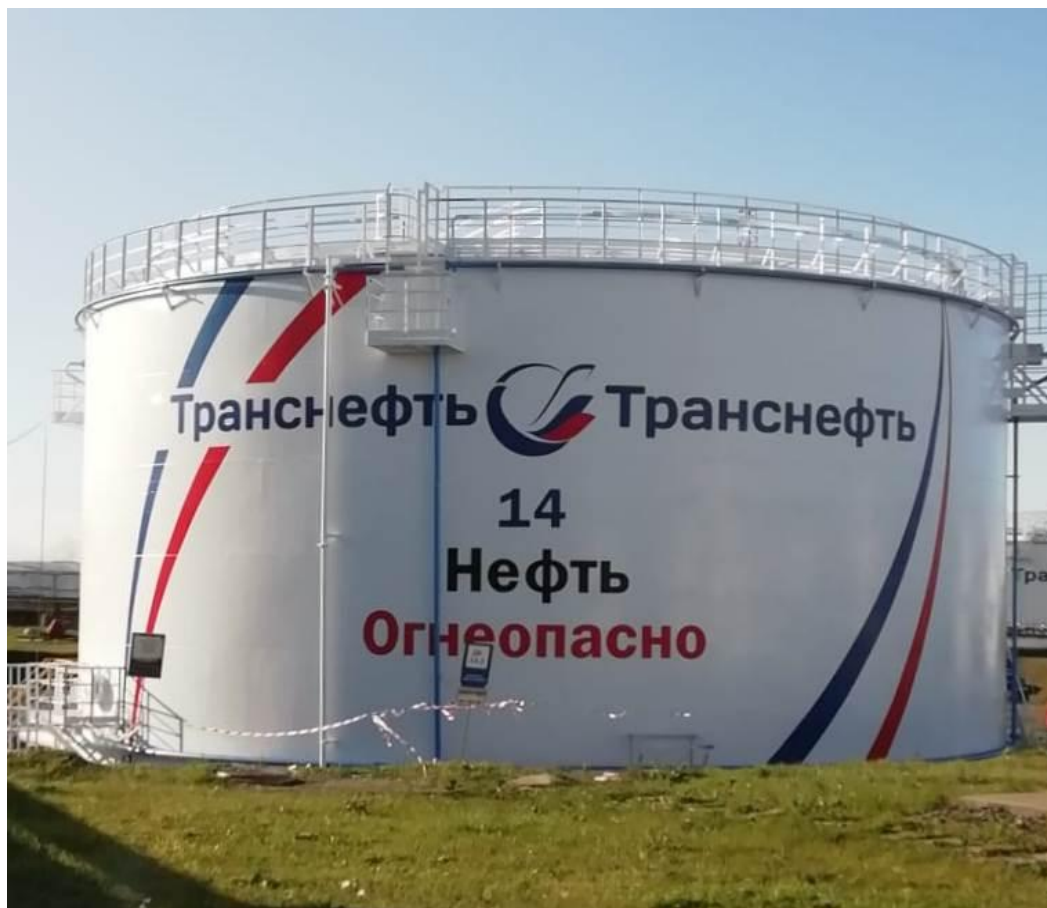
Рисунок 3 – Общий вид резервуара РВСП- 5000 зав.№ 14
