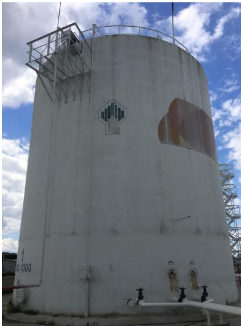
Рисунок 2 – Общий вид резервуаров стальных вертикальных цилиндрических РВС-1000
