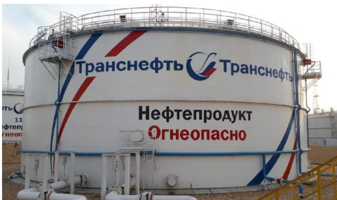
Рисунок 2 – Общий вид резервуаров РВСП-10000 зав.№№ 12, 15, 16
