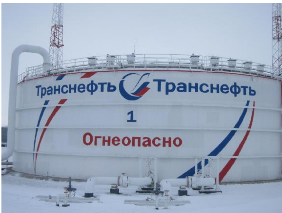
Рисунок 1 – Общий вид резервуара РВС-20000 зав.№ 1
