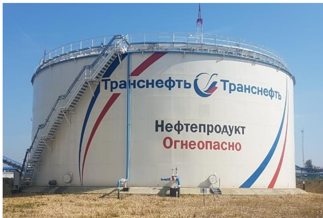
Рисунок 2 – Общий вид резервуаров РВС-10000 №№ 1, 16
