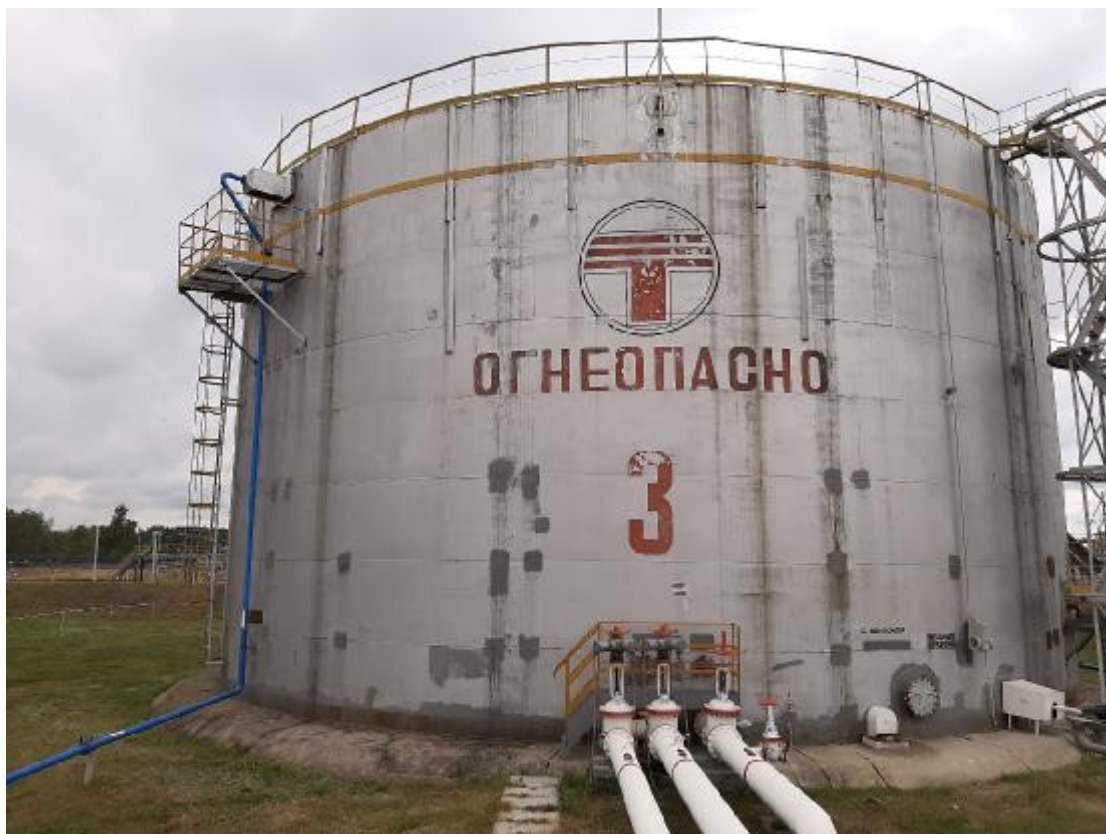
Рисунок 1 – Общий вид резервуара РВСП-5000 №№ 3
