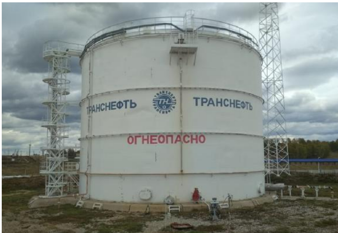
Рисунок 1 – Общий вид резервуаров РВСП-5000 зав.№№ 3, 10, 11, 12
