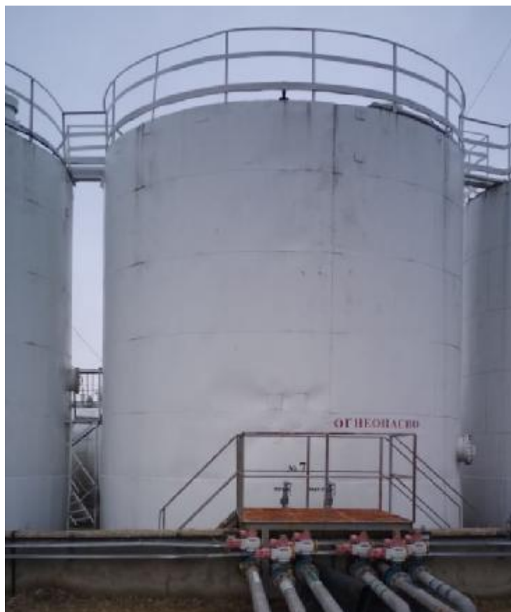
Рисунок 1 – Общий вид резервуара РВС-400
