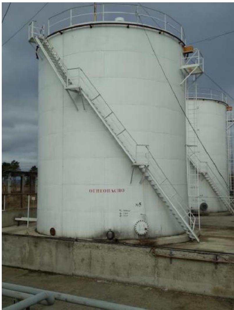
Рисунок 2 – Общий вид резервуара РВС-1000
