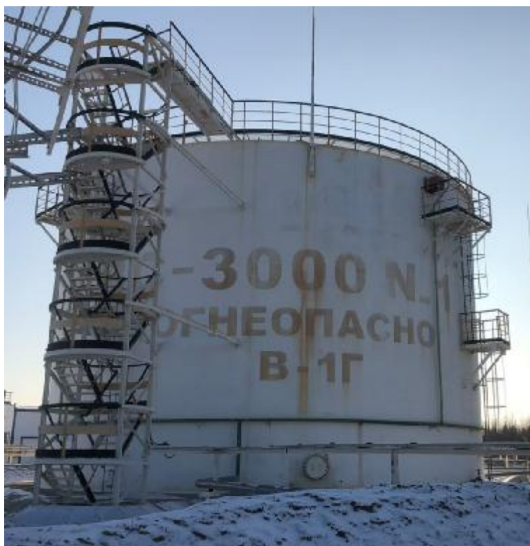
Рисунок 1 – Общий вид резервуаров стальных вертикальных цилиндрических РВС-3000
