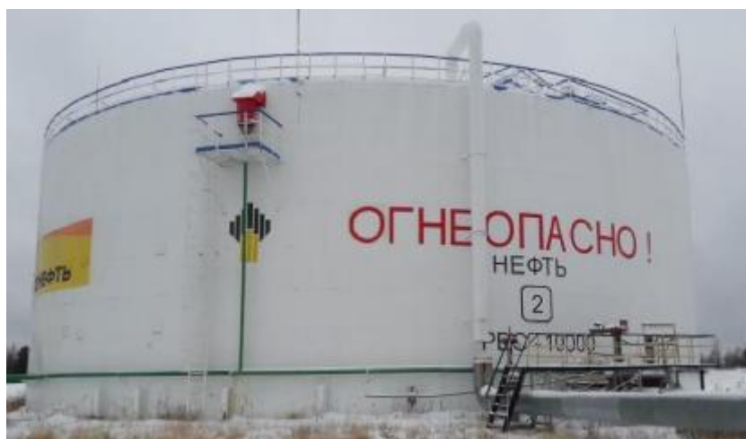
Рисунок 1 – Общий вид резервуаров стальных вертикальных цилиндрических РВС-10000
