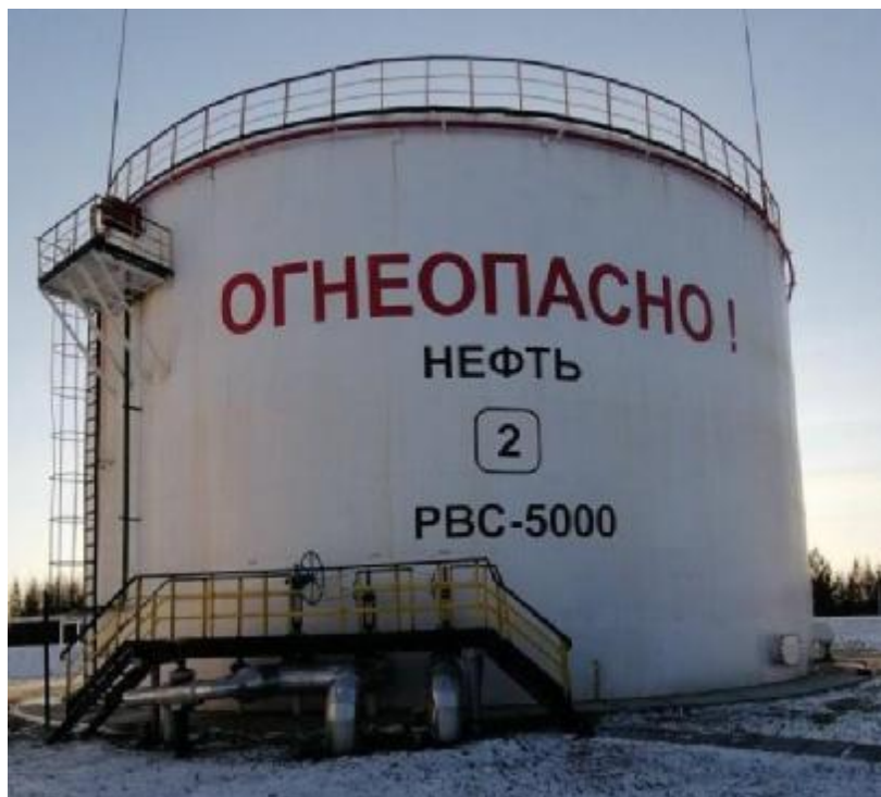
Рисунок 2 – Общий вид резервуаров стальных вертикальных цилиндрических РВС-5000
