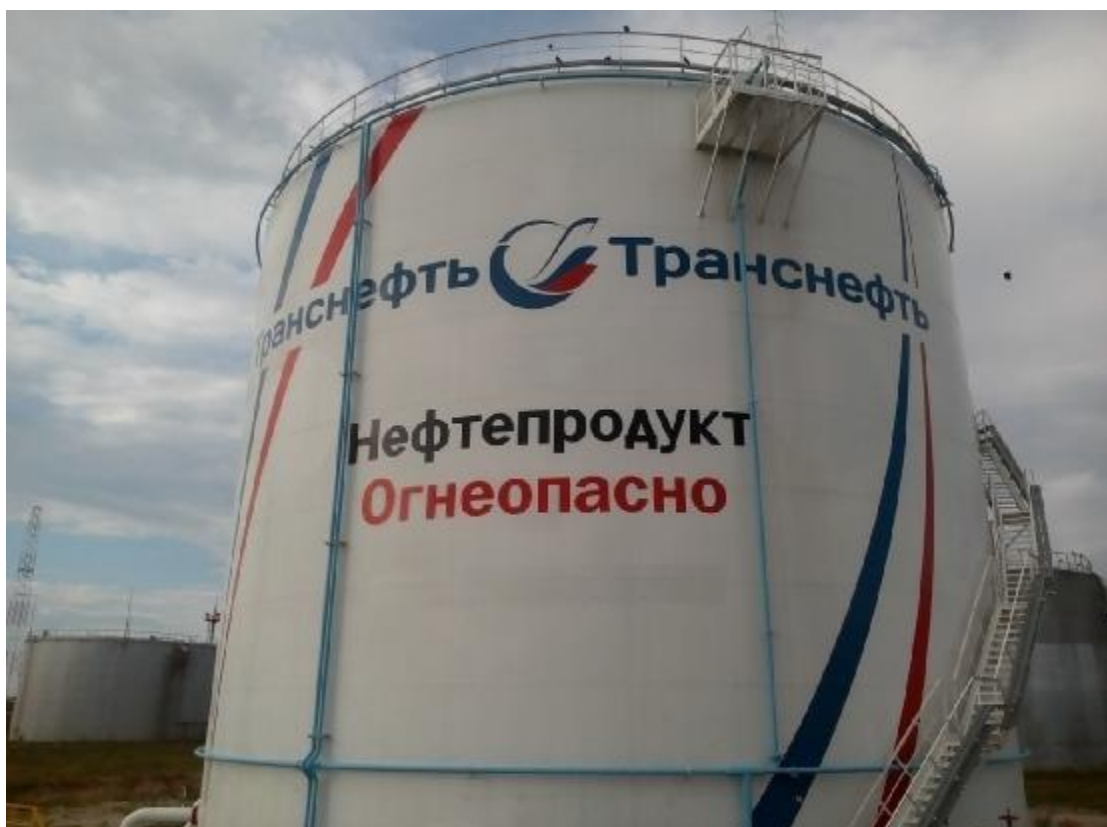
Рисунок 2 – Общий вид резервуаров РВС-7500 зав.№№ 10, 19
