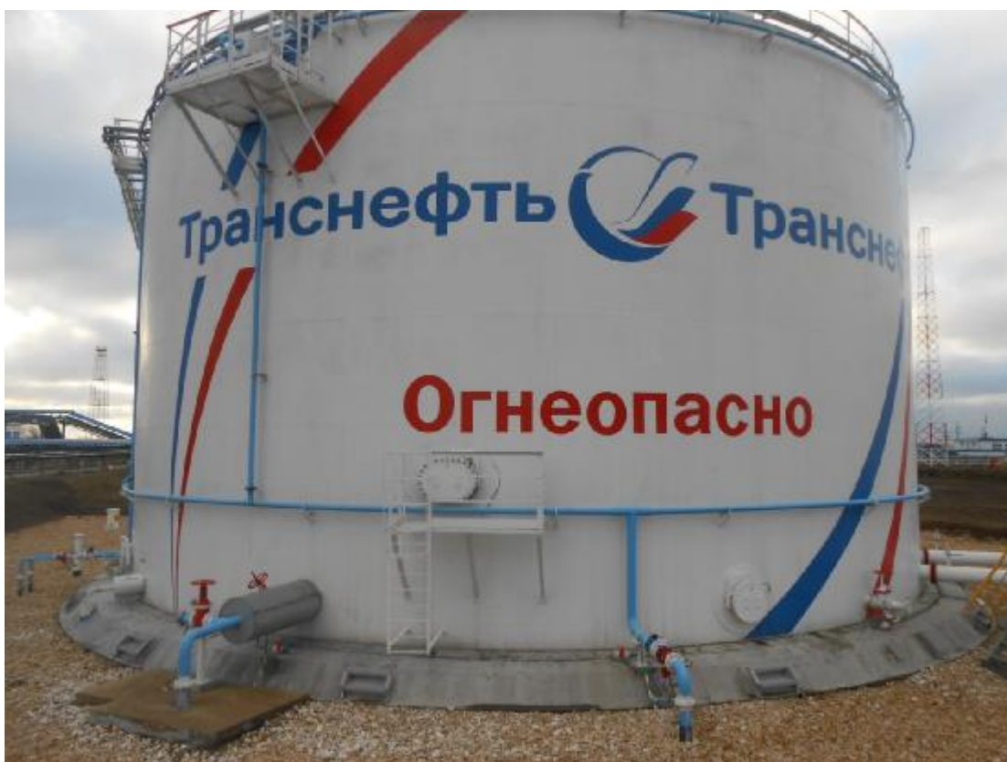
Рисунок 1 – Общий вид резервуаров РВСП-5000 зав.№№ 3, 14, 15
