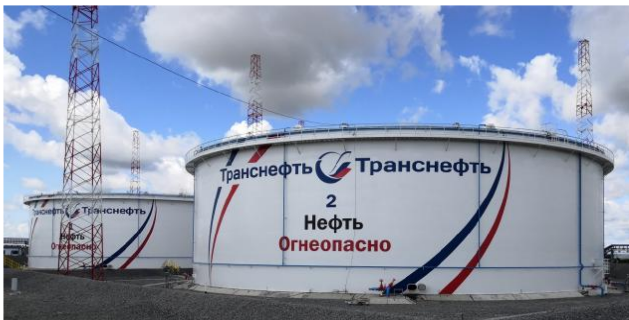
Рисунок 1 – Общий вид резервуаров РВСПК-50000 зав.№№ 1, 2
