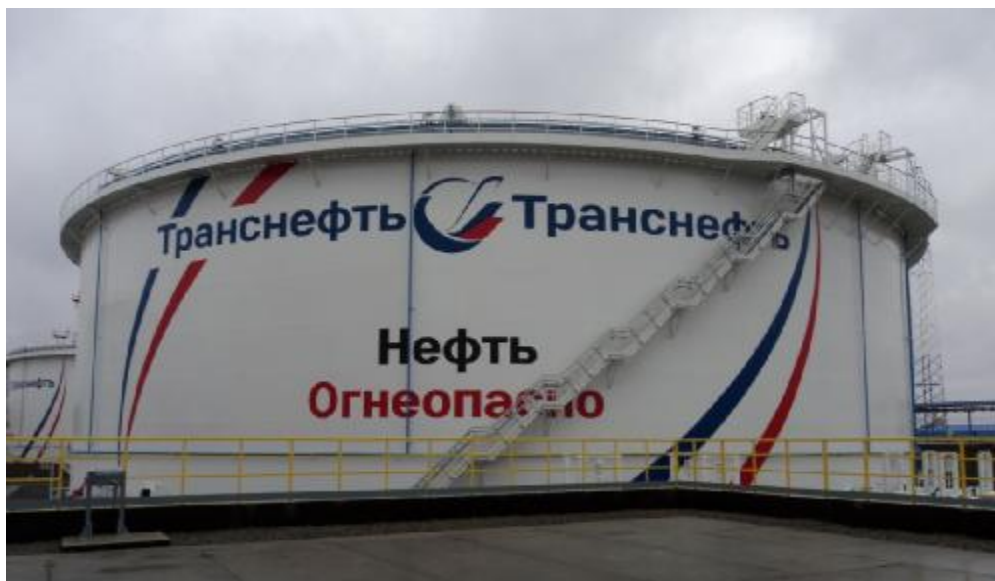
Рисунок 1 – Общий вид резервуаров РВСПК-50000 зав.№№ 4, 6, 7
